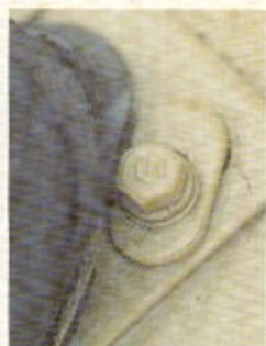
トランスミッション、リアけん引フックなど、一部のボルトにはSマークが入っている。
